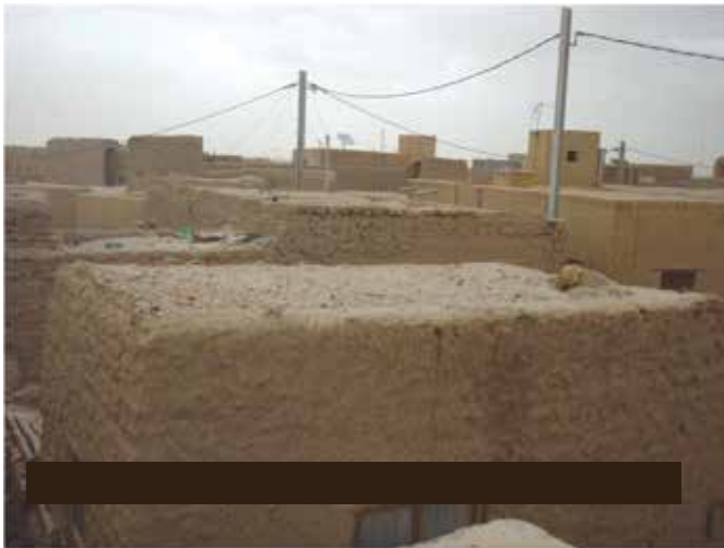
写真5 マリ・トンブクトゥの民家 (2010.8) 建物は屋根から溶けてゆく。
