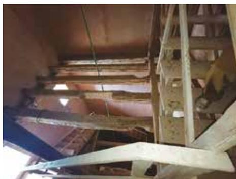
写真4 内部の階段と朽ちた梁
